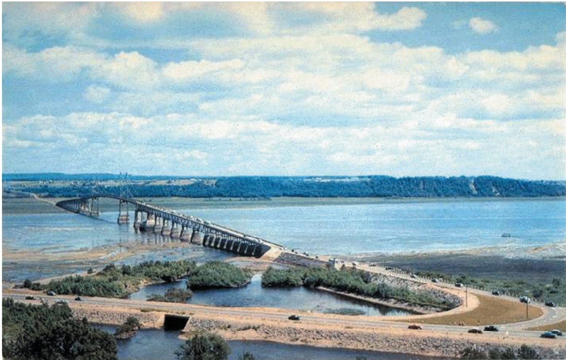
Isle D'Orléans bridge
